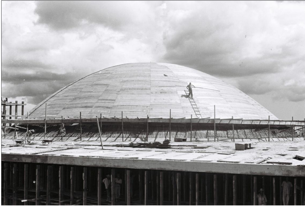
Figura 4: Construção do Congresso Nacional em Brasília. Fotografia Mário Fontenelle Fonte: Arquivo Público do Distrito Federal Cód. 0314 NOV B2
